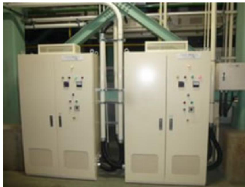
(事例2) 冷却ファンの運転を商用からインバータへ変更
