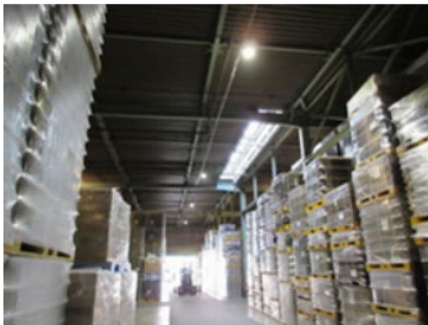
(事例1) 倉庫内の高圧ランプ照明をLED照明に変更
